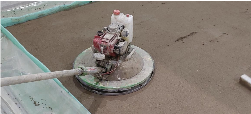
Kuva 1. Maakostean betonin tasoitusta
