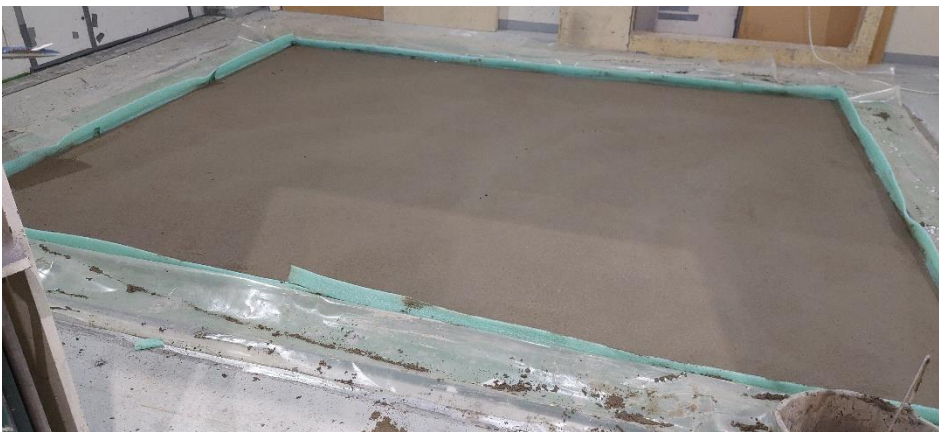
Kuva 2. Maakostea betoni asennettuna
